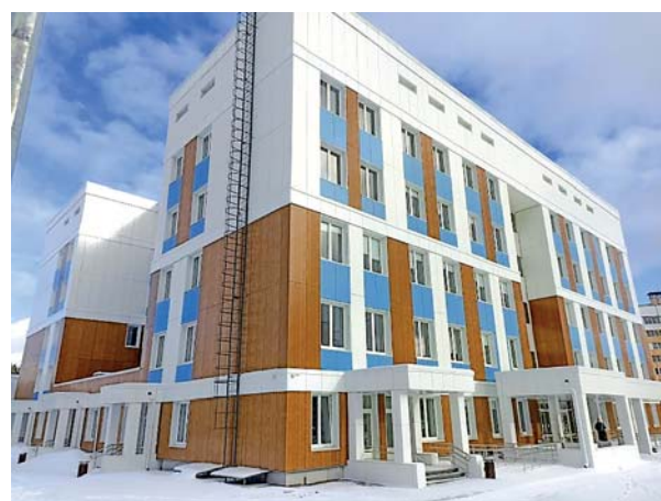
Здание новой поликлиники
